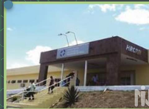
HOSPITAL REGIONAL Dr. C. Rodrigues de Mello Santana do Ipanema - AL
