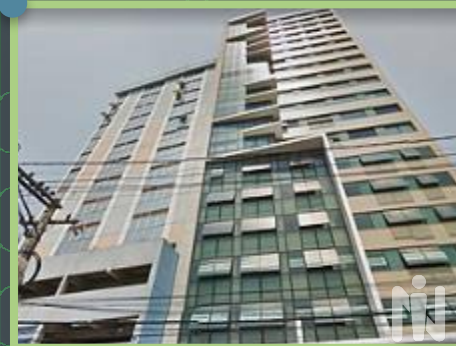
ESCRITÓRIO ADMINISTRATIVO São Gonçalo - RJ
