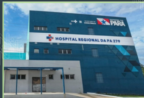
HOSPITAL REGIONAL DA PA 279 OURILÂNDIA - PA
